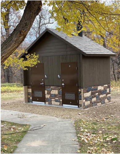
Pour concrete pad in front of new vault toilet.
