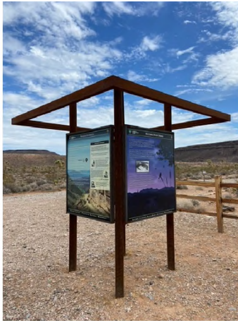
Install New Kiosks
